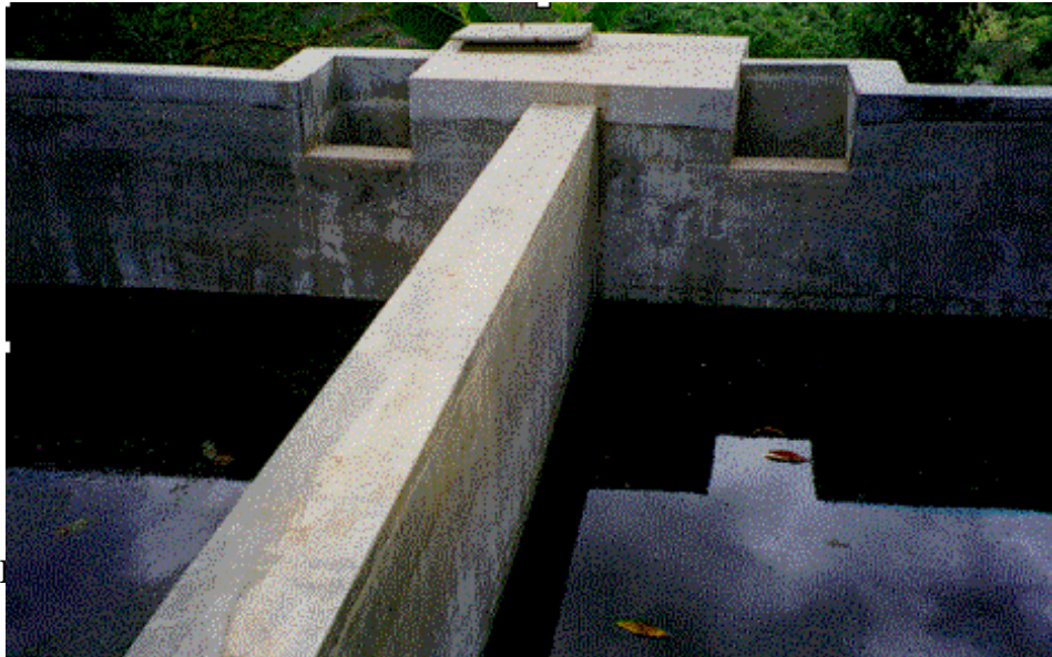
Figura A9.4. Estructura de Salida.
