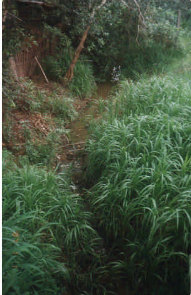
Fotografía 42. No sólo nos encontramos filtraciones a la Quebrada del Salto, sino también en la parte oeste de Puerto Nariño.
