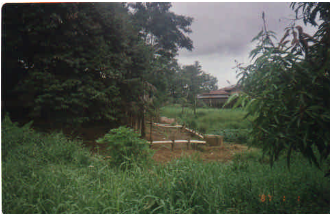
Fotografía 24. Aproximadamente un 20% de la población de Puerto Nariño, está dotada de Alcantarillado
