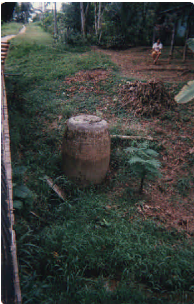
Fotografías 30 y31. Vista de un pozo ciego, que filtra sus aguas negras a la Quebrada del Salto.
