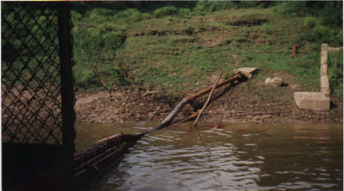
Fotografía 9. El bombeo se realiza mediante una tubería de 6"
