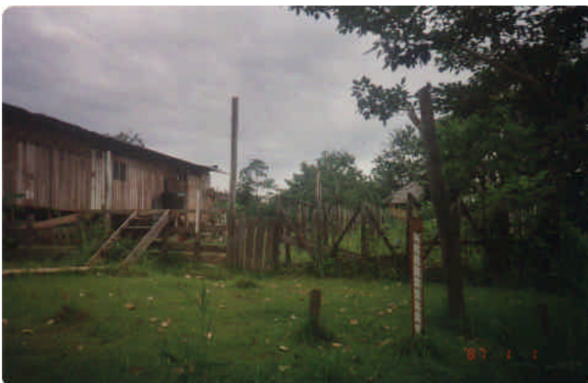
Fotografía 52. Miras en la parte superior, necesarias puesto que el nivel del río llega a subir hasta 14 metros.
