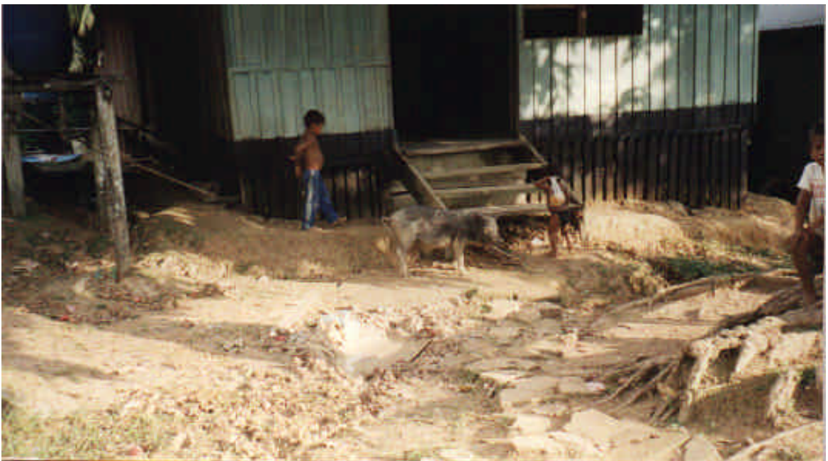
Fotografía 45. Los desechos de los animales tampoco se encuentran recogidos por el Alcantarillado de Puerto Nariño.
