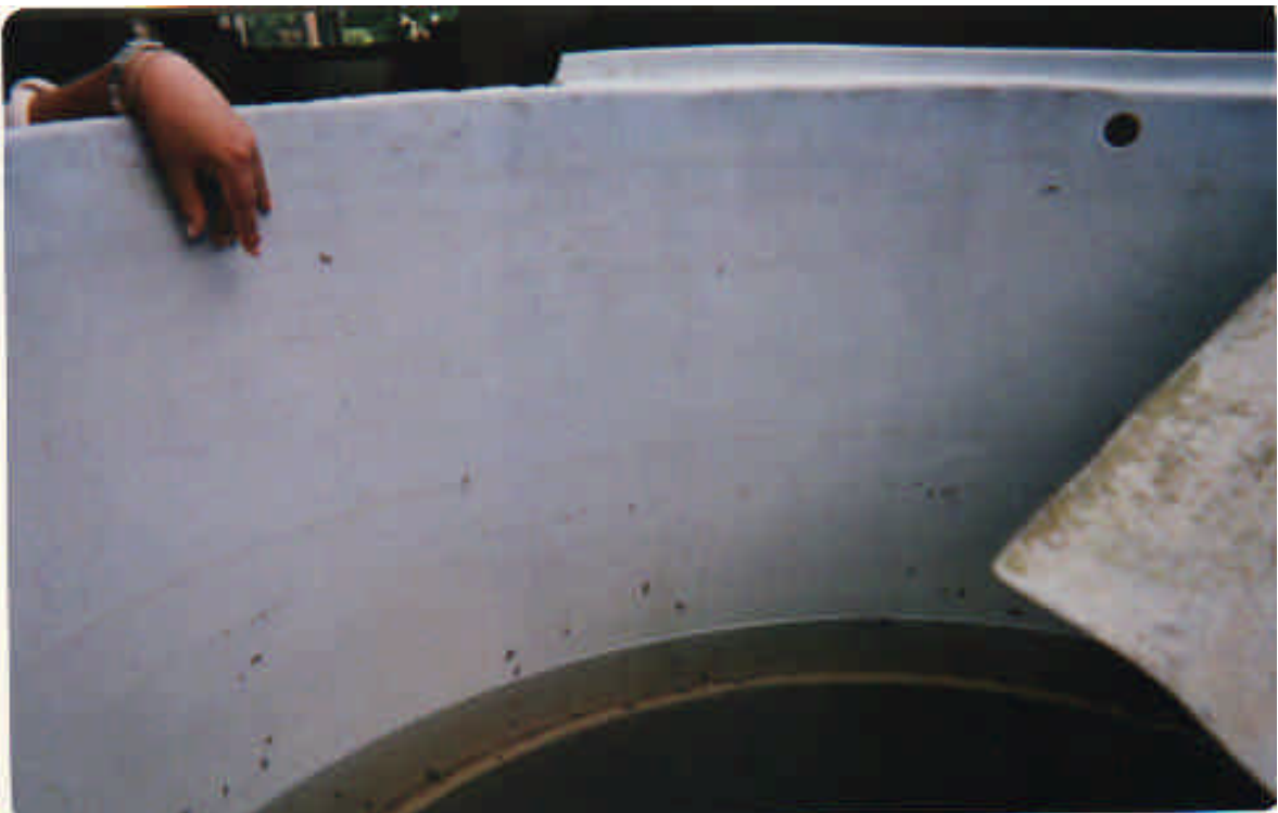
Fotografía 23. En este tanque se puede observar la pésima calidad del agua.
