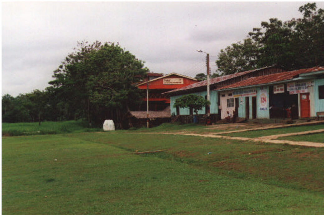
Fotografía A1.1 Localización del Pozo de Registro N° 1, tomado como Origen de Coordenadas
